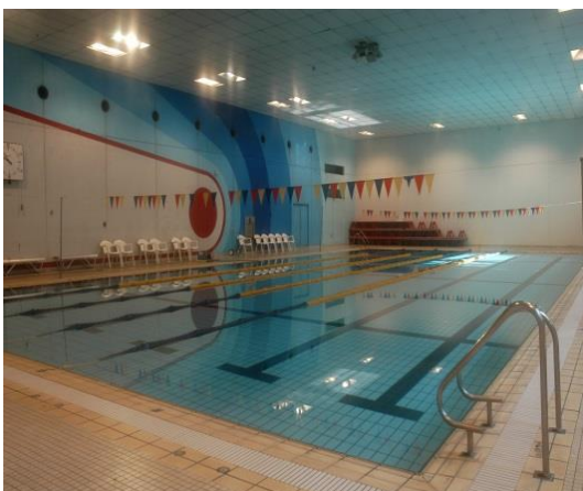
太子堂中学校 温水プール
